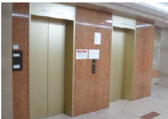
1F エレベーターホール
